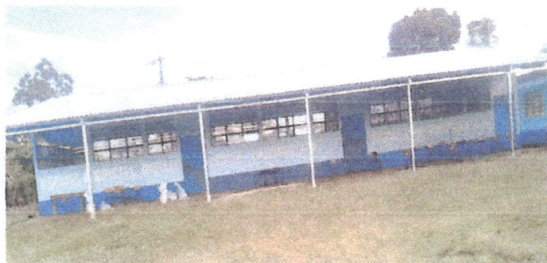
Foto1: MODULO 1. Este modulo se observa el trabajo finalizado
