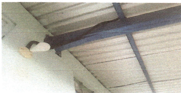
Foto 3: MODULO 3. Este módulo, se observa la instalacion fue finalizado
